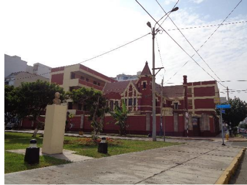
Figura 14 Facultad de Ingeniería Civil de la UNFV
