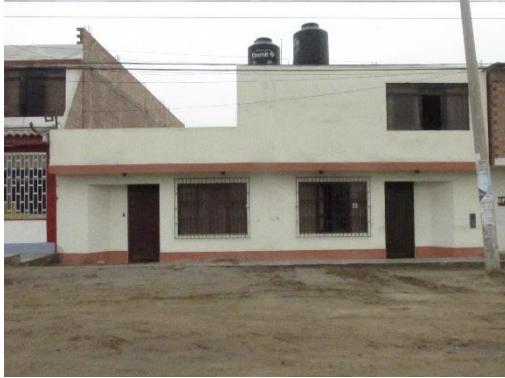
Figura 6: Vivienda de albañilería confinada de dos niveles en topografía plana.
