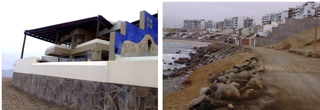
Figura 8. Viviendas de albañilería de tres niveles.
