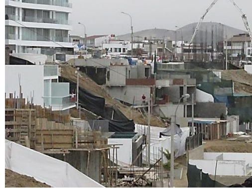
Figura 7: Vivienda de albañilería confinada de tres niveles adaptada a la pendiente del terreno.
