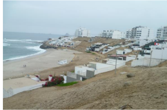
Figura 10. Edificio de concreto armado del Sector 02.
