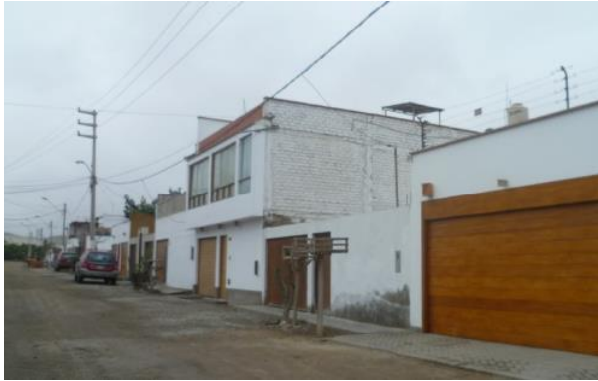
Figura 9. Vivienda de albañilería confinada del Sector 02.
