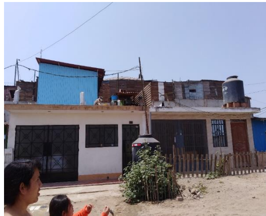
Viviendas con Material de Ladrillos
