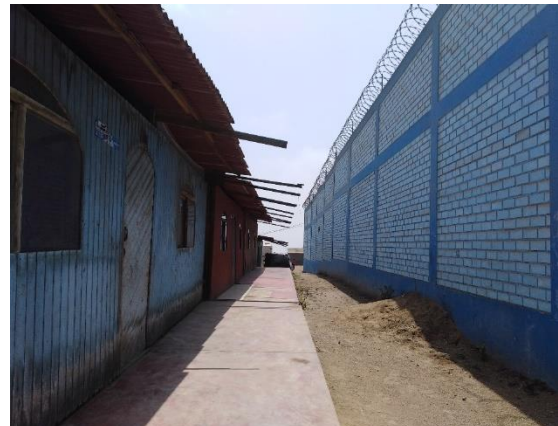
Vista del espacio angosto entre el tanque de agua y viviendas
