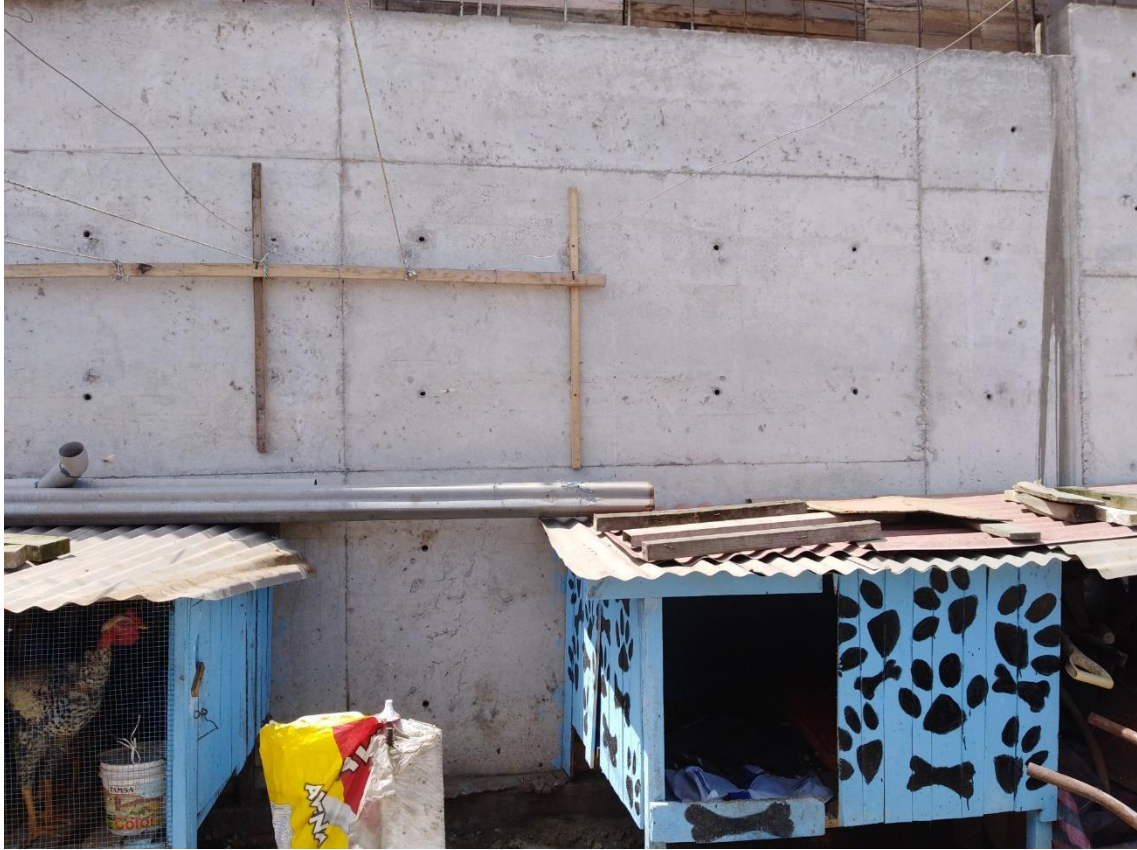
Vista del Muro de concreto
