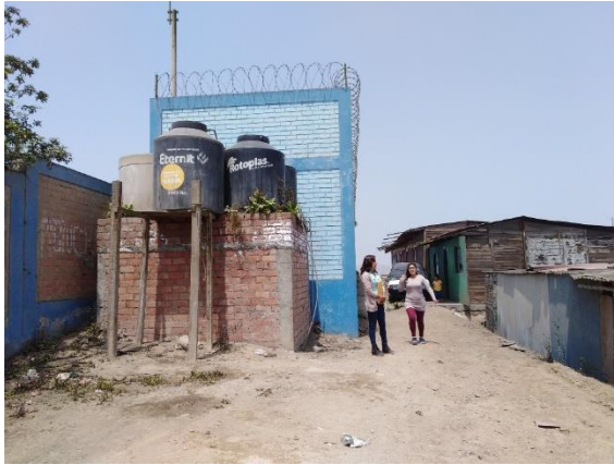
Volados de viviendas muy próximas a postes de alumbrado y redes públicas.
