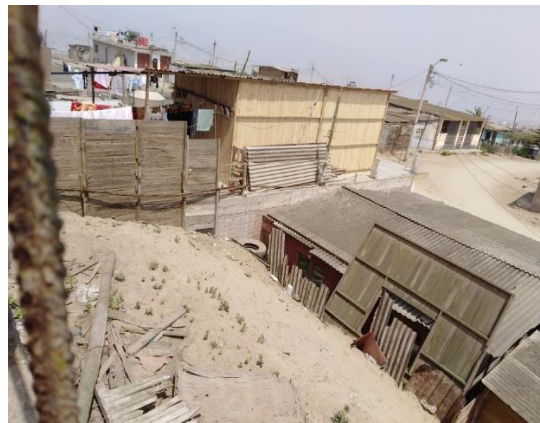
Se aprecia el desnivel de la Mz B. de 6 metros
