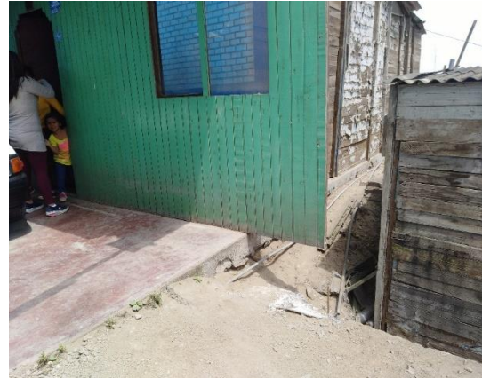
Edificaciones con volados hacia la vía pública
