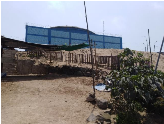
Vista del tanque de agua en la parte alta
