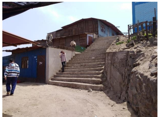
Muro de enrocado en la parte inferior de tanque de agua.
