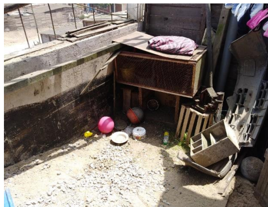
Muro de concreto en Viviendas
