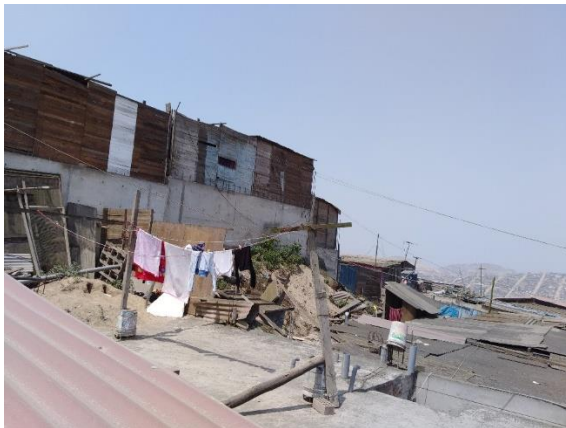
Desnivel de Viviendas con material de Madera
