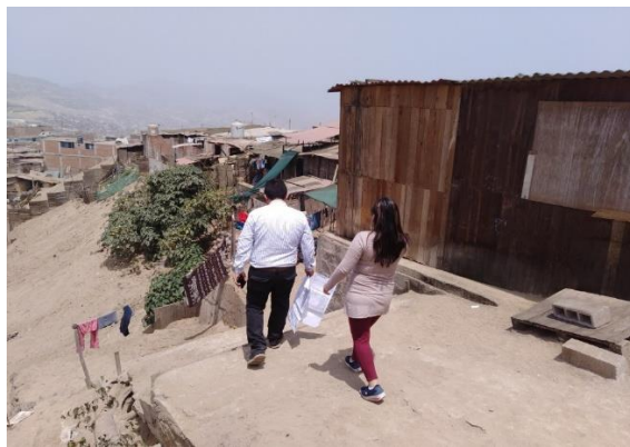
Pasaje interior mal estado para la evacuación.
