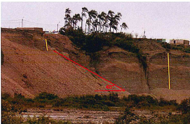
Foto 27. Pendientes del terreno, en el sector de Cruz del Río. En las líneas de color amarillo, se indican pendientes casi verticales del talud. Las pendientes menores se relacionan a talus de detritos del mismo material aluvial caído.
