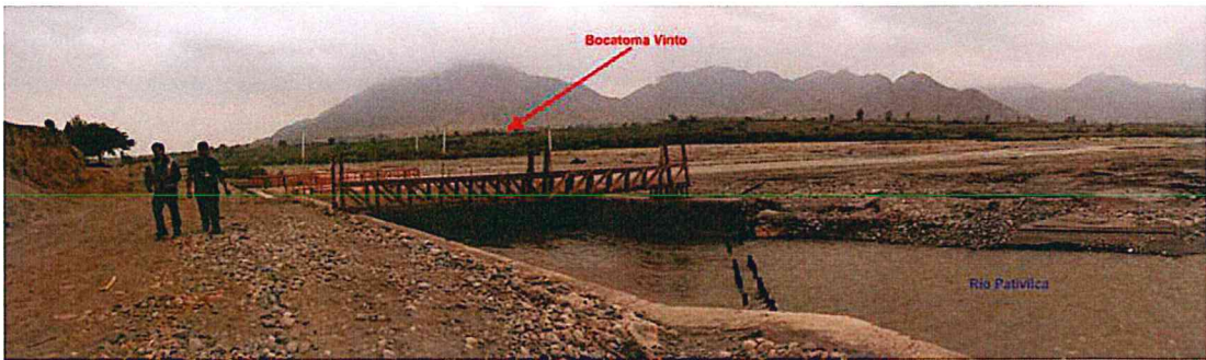
Foto 13. Bocatoma Vinto, ubicada en la margen izquierda del río Pativilca.
