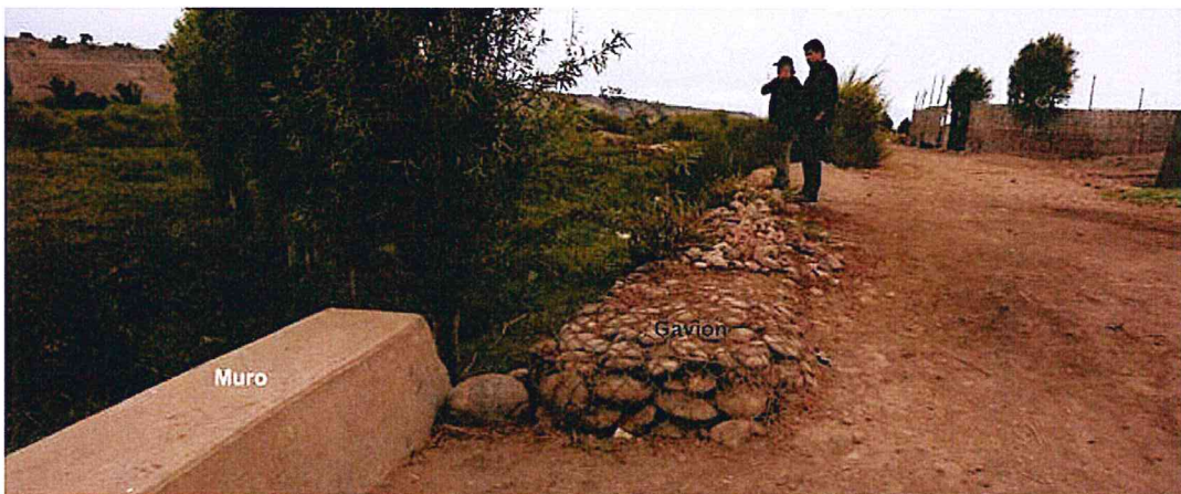
Foto 19. Se aprecia las defensas ribereñas, el muro de concreto y gavión.
