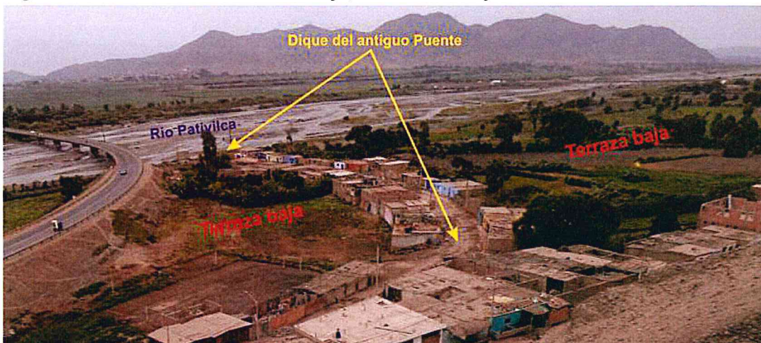
Foto 20. Se aprecia viviendas ubicadas en el dique del antiguo puente Pativilca.
