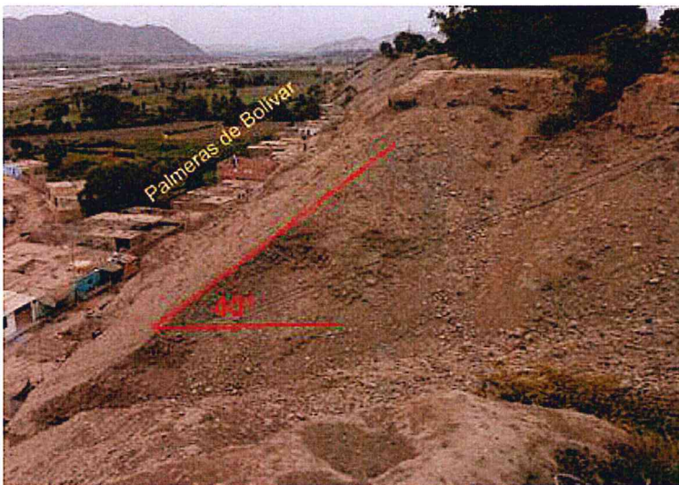
Foto 26. Pendiente del terreno, en el sector de Palmeras de Bolívar.
