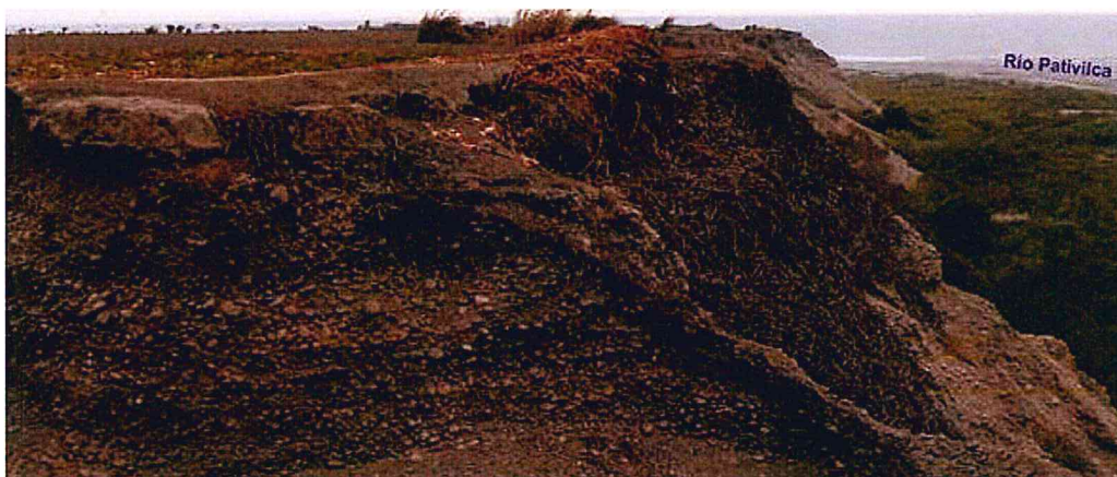
Foto 24. Se muestra el talud, conformado por un conglomerado masivo en la base, poco consolidado y de gran espesor cubierto en el tope por una secuencia de arena fina.
