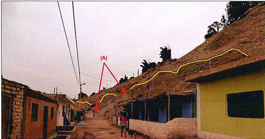
Foto 28. Cortes de talud (líneas de color amarillo) y conos de derrubios (A).
