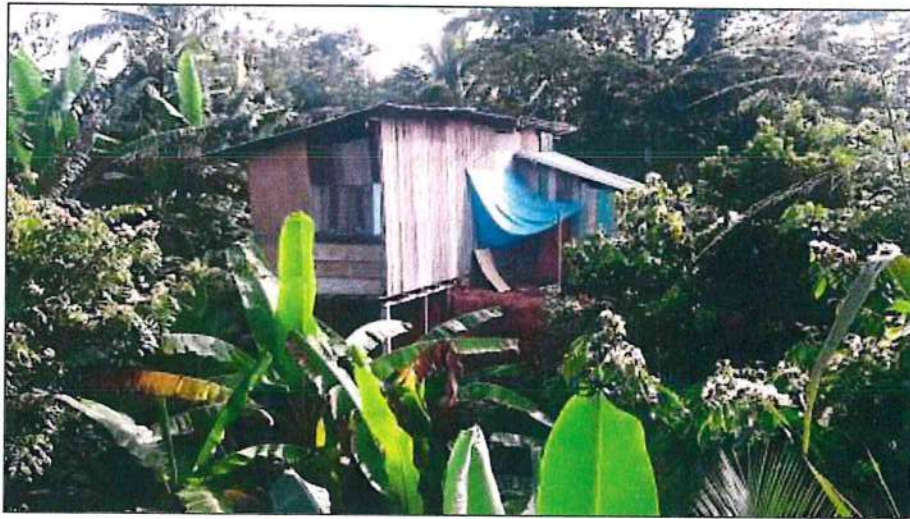
Foto 20: Vista de una vivienda ubicada en el cuerpo de la cárcava.
