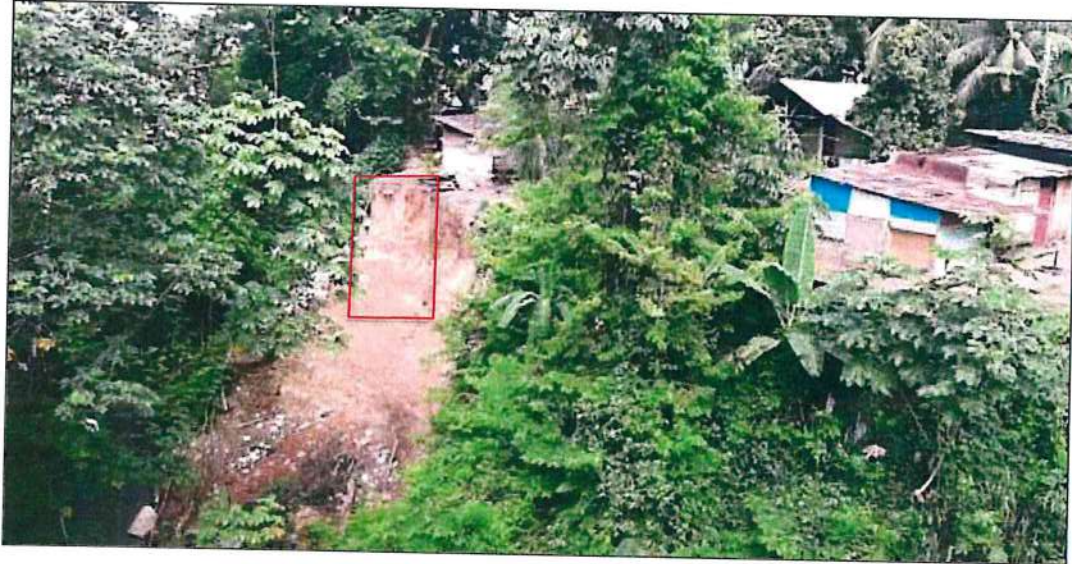
Foto 4: Vista del derrumbe, a la margen izquierda de la cárcava.
