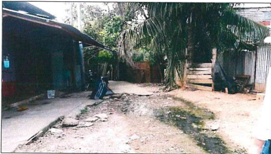
Foto 21: La filtración de agua hacia las calles que conectan directamente a la Cárcava.
