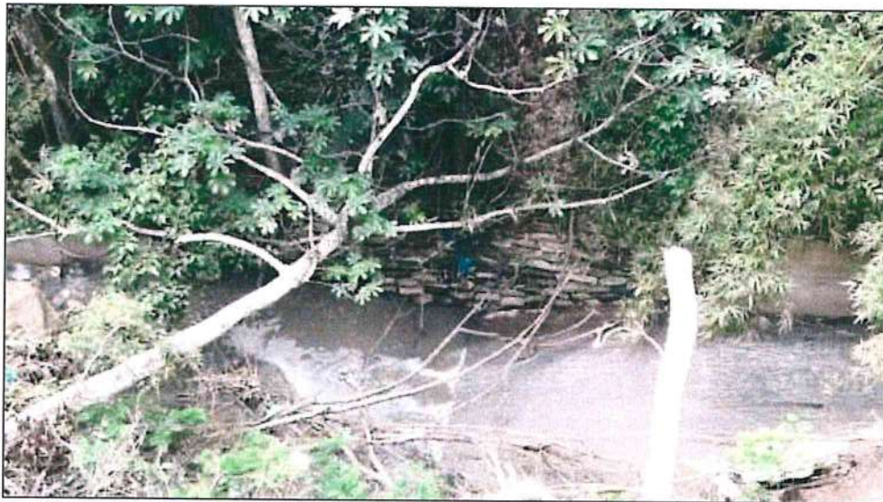
Foto 17: Vista de bolsacretos en la base del canal colector.
