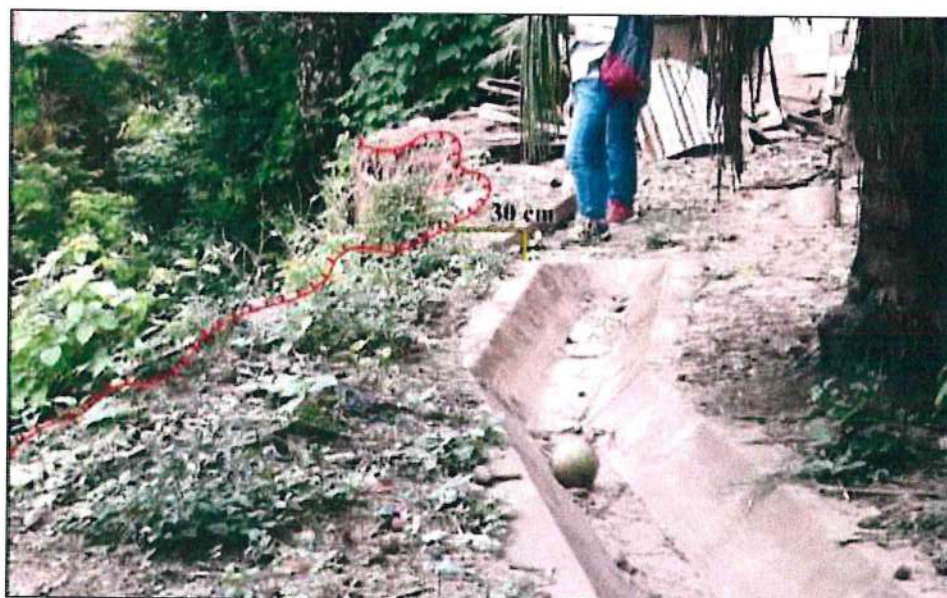
Foto 9: Canal de drenaje a 30 cm del escarpe.
