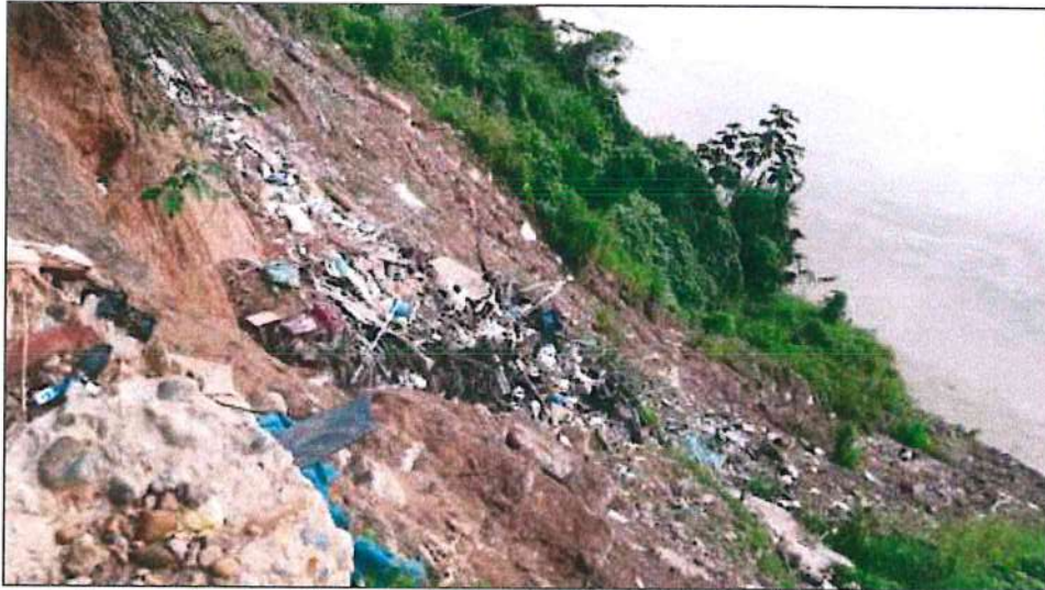
Foto 1: Margen derecha del río Madre de Dios, frecuentemente se genera erosión fluvial producto de la dinámica fluvial del río.
