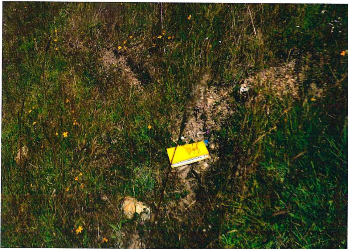
Fotografía 28: Agrietamiento en la ladera del Sector Rucuchijirca.
