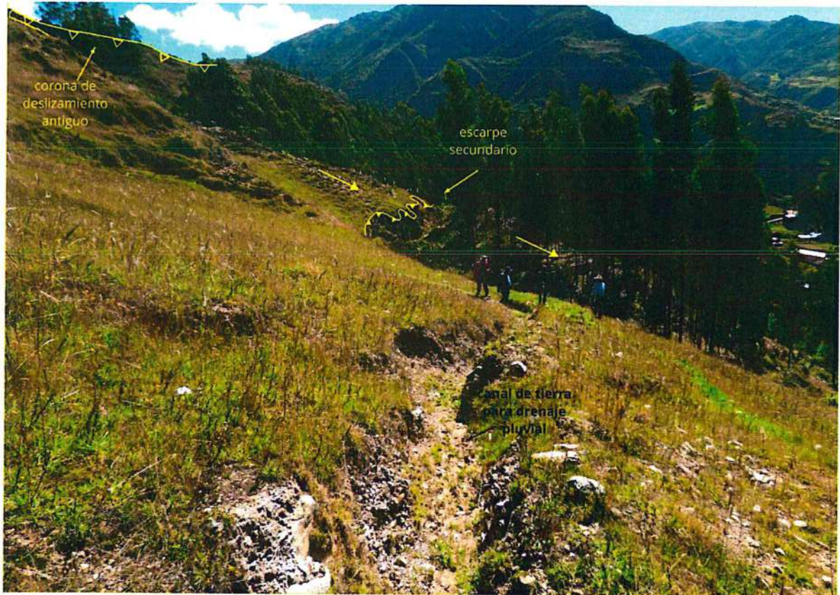
Figura 20: Deslizamiento antiguo en ladera Rucuchujirca.
