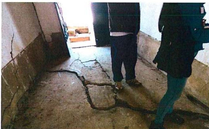
Fotografía 11: (Izquierda) Pared interna de la vivienda la cual presenta agrietamiento vertical con aberturas de 1 a 5 cm. Fotografía 12: (Derecha) piso de vivienda fracturado y levantado con aberturas de 6 a 7 cm de ancho.
