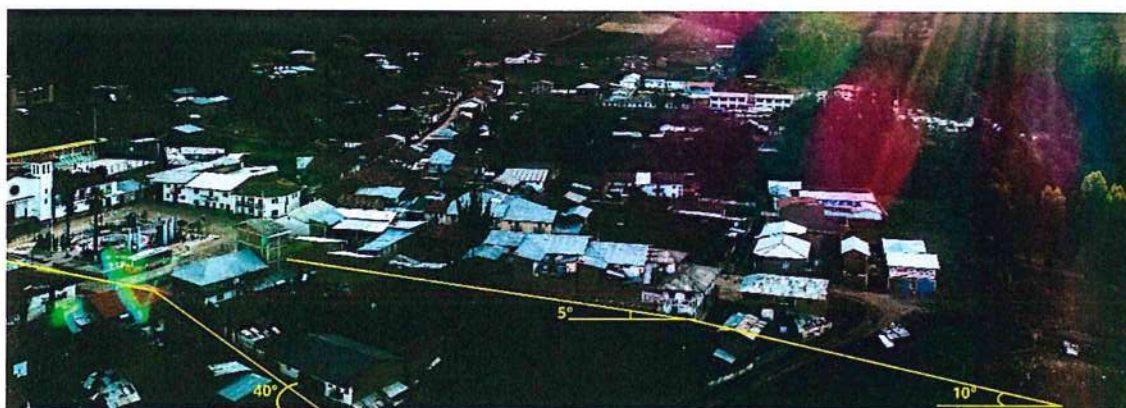
Figura 3: Vista aérea del poblado de Parobamba donde se visualiza la variación de pendientes mediante línea amarilla. La zona de menos pendiente corresponde a la plaza principal.
