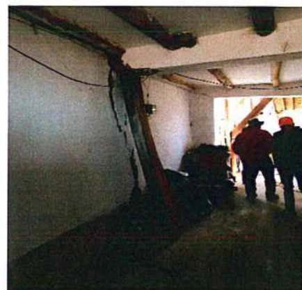
Fotografía 11: (Izquierda) Pared interna de la vivienda la cual presenta agrietamiento vertical con aberturas de 1 a 5 cm. Fotografía 12: (Derecha) piso de vivienda fracturado y levantado con aberturas de 6 a 7 cm de ancho.
