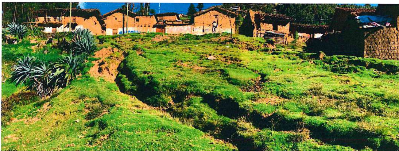
Fotografía 25: Proceso de reptación de suelos al Noreste de Parobamba Alto.
