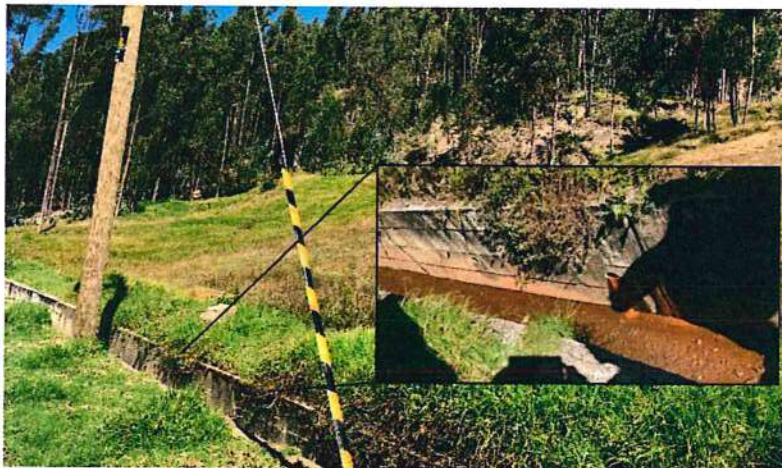
Figura 23: Canal de drenaje cercano a deslizamiento reciente.
