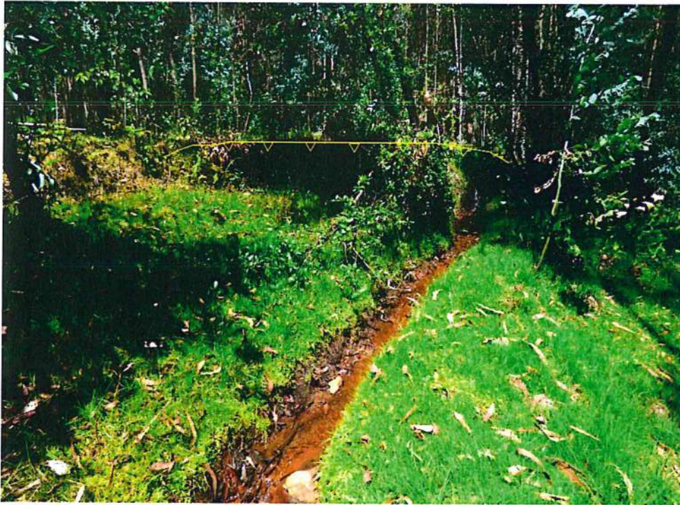
Figura 13: Escarpe de deslizamiento, manantial y canal de agua sin revestir en el sector Asiacochoa.
