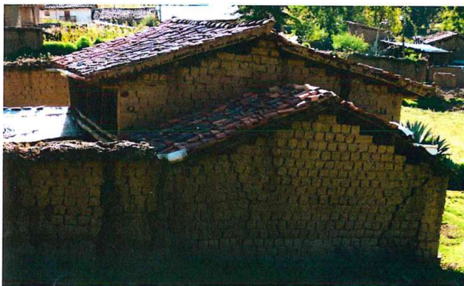
Fotografía 26 (izquierda) y figura 14 (derecha): Muestran agrietamiento longitudinal característico de contracción de suelos arcillosos al Noreste de Parobamba.
