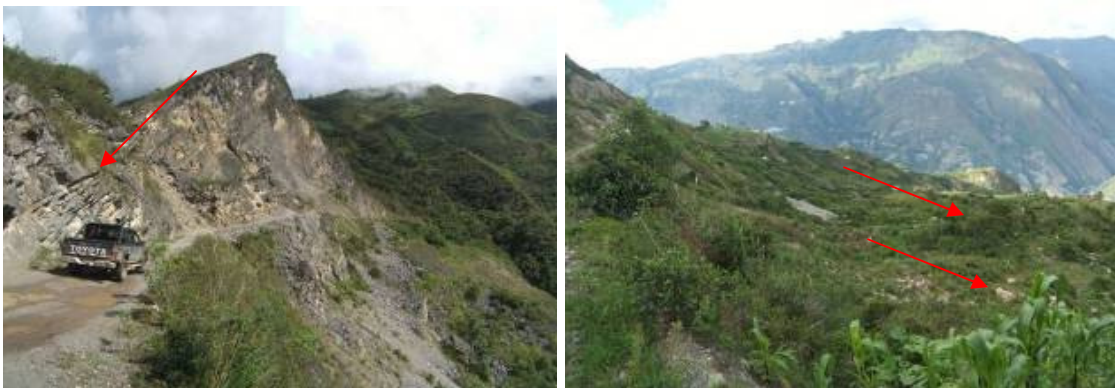
Fotos 1 y 2. Morfología en las laderas de las capas del Grupo Pulluicana. Izquierda: Laderas escarpadas formadas por estratos de calizas en la vía San Luis de Lucma a La Ramada. Derecha: Ladera cóncava en la margen izquierda del río Conchán-Tacabamba, asociada a un deslizamiento antiguo.
