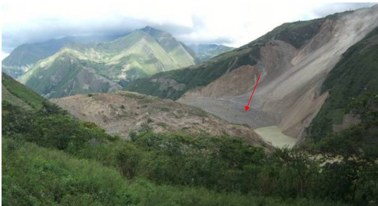
Foto 9. Vista de la zona del embalse. Notar el material que continua derrumbándose al pie del depósito de embalse del río Súcota.
