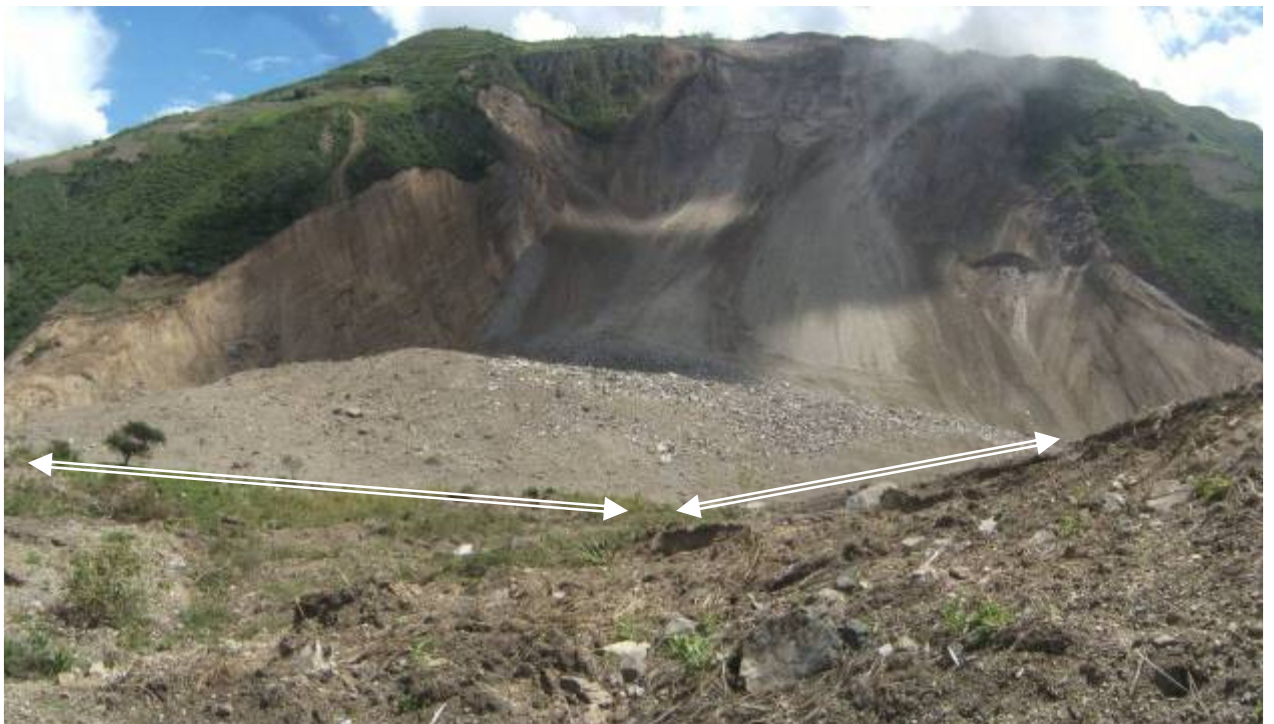
Foto 14. Detalle de la foto anterior que muestra una zona baja entre la zona del embalse mayor y el material que sigue derrumbándose.
