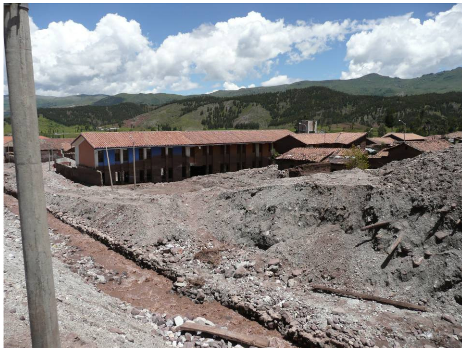
Foto 18: Vista post evento del Colegio de Zurite, nótese que la mancha de lodo llega al segundo nivel del edificio principal del colegio.
