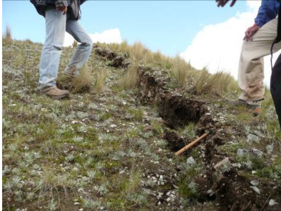
Foto 5: Las grietas tensionales tenían alturas promedio de 0.40 – 0.50 cm. Esta altura podría aumentar considerablemente durante la siguiente temporada de lluvias.
