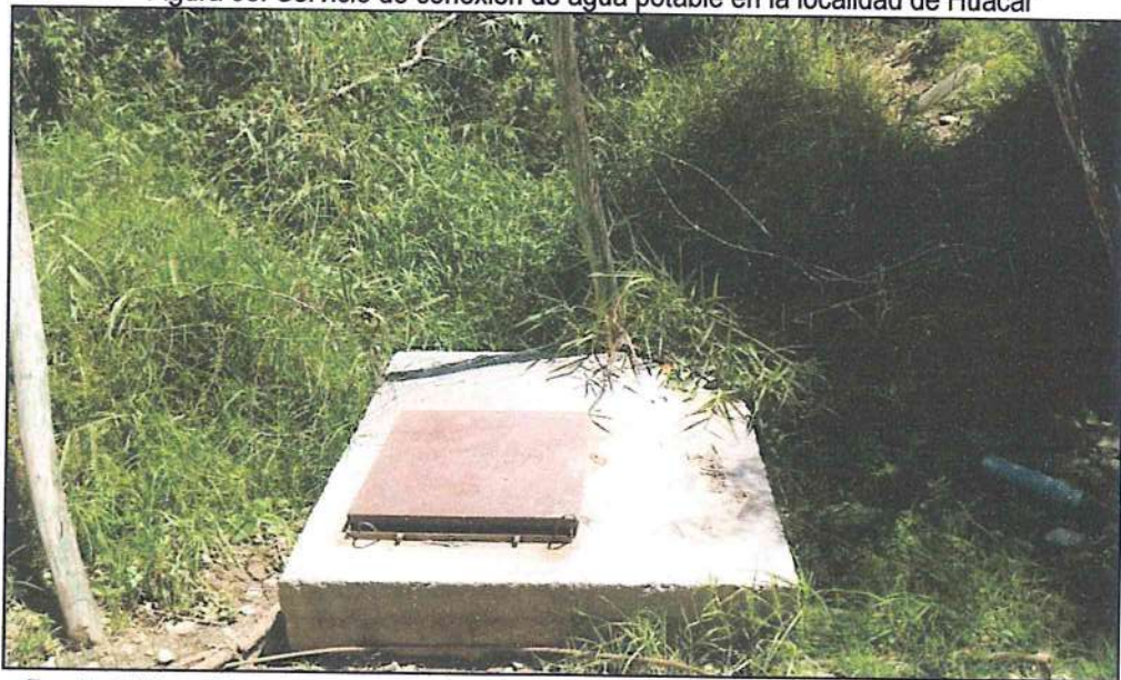
Figura 08: Servicio de conexión de agua potable en la localidad de Huácar
