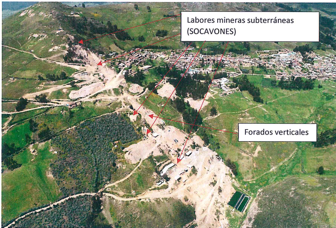
Figura 14. Evidencias de laboreo minero subterráneo artesanal y de mediana minería desarrollado a inmediaciones del poblado de Salpo que provocaron hundimientos y caída de rocas en enero y febrero del 2019 afectando a una carretera de losa de concreto poniendo en peligro a la seguridad física de personas, vehículos que transitan por esta vía, así como también la de 8 viviendas y la comisaría de Salpo. Fuente: Elaboración Propia 2019
