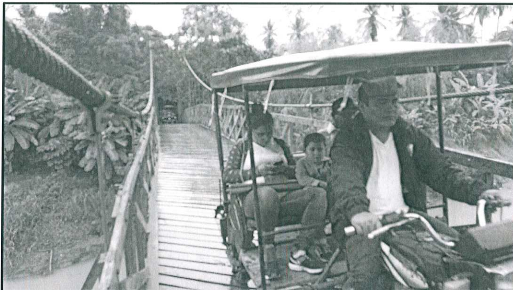
FOTO N° 03: Infraestructura Hidraulica-Puente Vehicular
