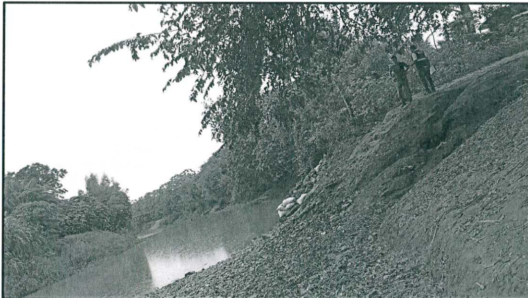
FOTO N° 02: Cauce lado Izquierda del Brazo del rio Huallaga
