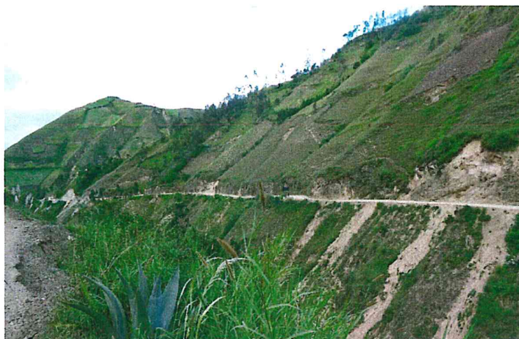
Vista de laderas de montañas que caracterizan el territorio 04 de Chalaco. Observar la pendiente Pronunciada desprovista de una buena cobertura vegetal y con un diseño de drenaje paralelo.
