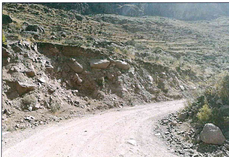
Foto 3: Depósitos coluviales matriz soportados, con presencia de bloques angulosos de hasta 2.00 m de diámetro
