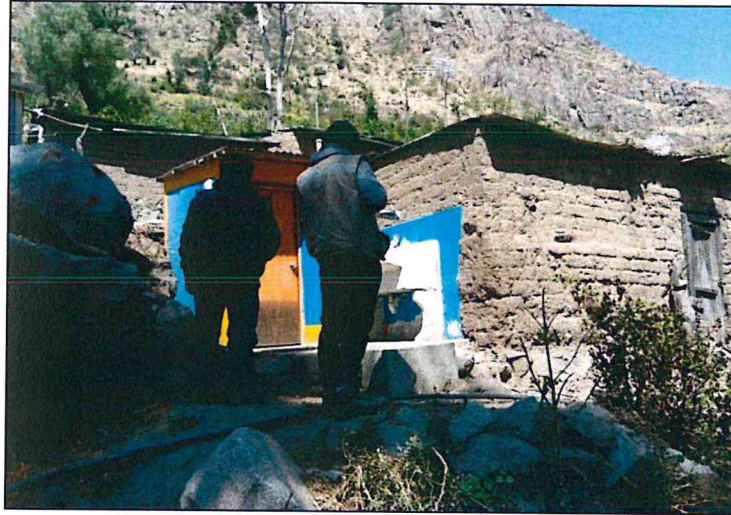
Figura 02: Viviendas de adobe con techos de calamina
