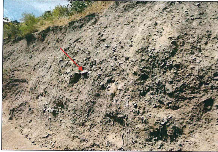
Figura 04: Depósitos aluviales antiguos, conformando terrazas aluviales en la margen izquierda del río Chiris.
