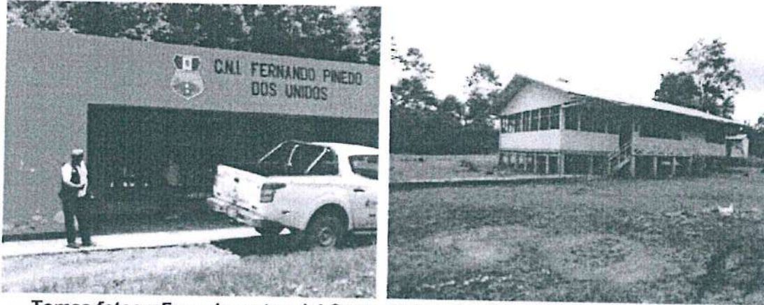
Tomas fotograficas de restos del Centro Educativo C.N.I Fernando Pinedo – Dos Unidos – Centro Salud, ubicado en la CC. NN. Dos Unidos que se encuentra en peligro Inminente.
