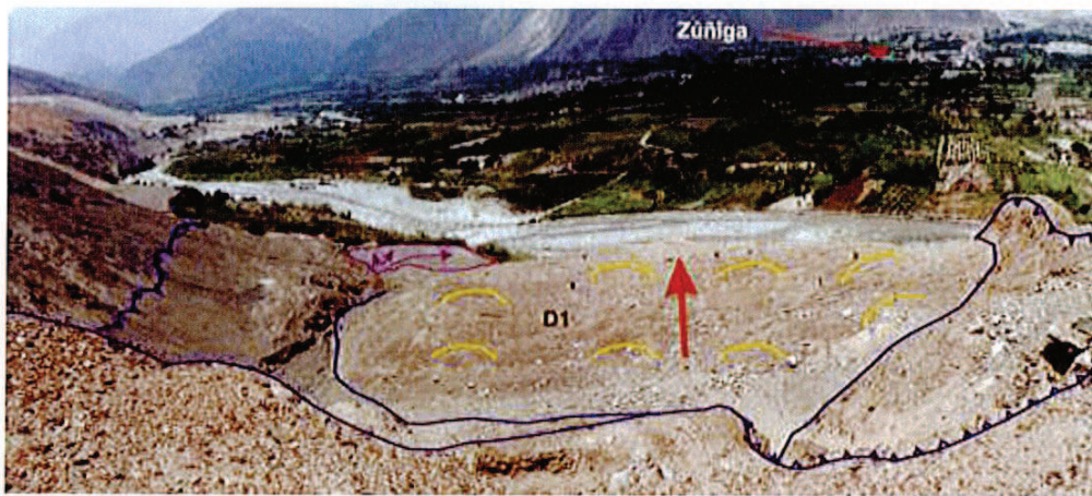
Foto 13: Vista lateral abajo del deslizamiento "D1", se ha resaltado con línea azul la escarpa y el cuerpo del deslizamiento, se señala también con una línea roja la dirección del movimiento; el ancho máximo del deslizamiento es de 180 m.
