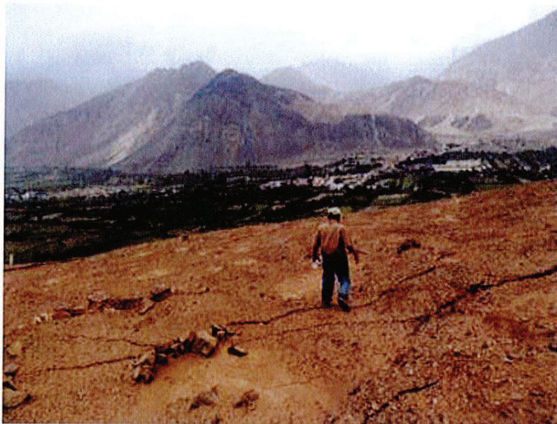
Foto 26: Agrietamientos paralelos en el flanco derecho del deslizamiento.
