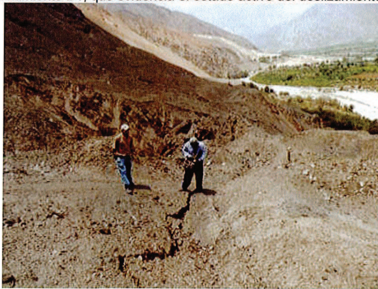
Foto 17: Grietas con aberturas de hasta 0,20 cm en el cuerpo del deslizamiento D1.
