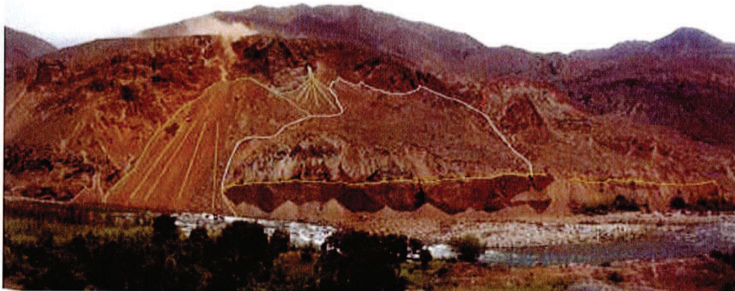
Foto19: Vista frontal del deslizamiento del Cerro San Francisco Orcco "D2", se ha señalado con línea blanca el cuerpo del derrumbe antiguo, así mismo se ha diferenciado con líneas amarillas la superficie inferior del derrumbe, también se señala con líneas color verde claro los conos de talus que se forman por el material que se colapsa. Es posible ver una polvareda de color anaranjado en el lado izquierdo de la foto en la parte superior del acantilado.
