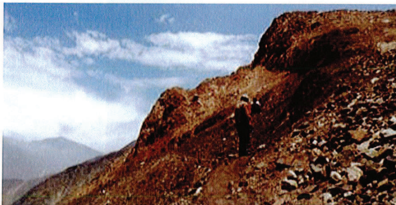
Foto 11: Vista lateral, donde es posible observar el salto principal del deslizamiento D2, de aproximadamente 6 m, también se puede observar parte de la superficie de falla del deslizamiento.
