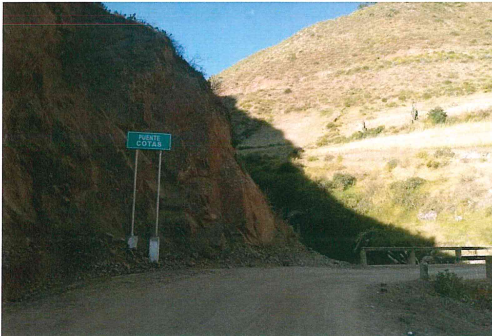
Imagen N° 13: Afloramiento de la Formación Hualhuani, en las inmediaciones del puente Cotas.
