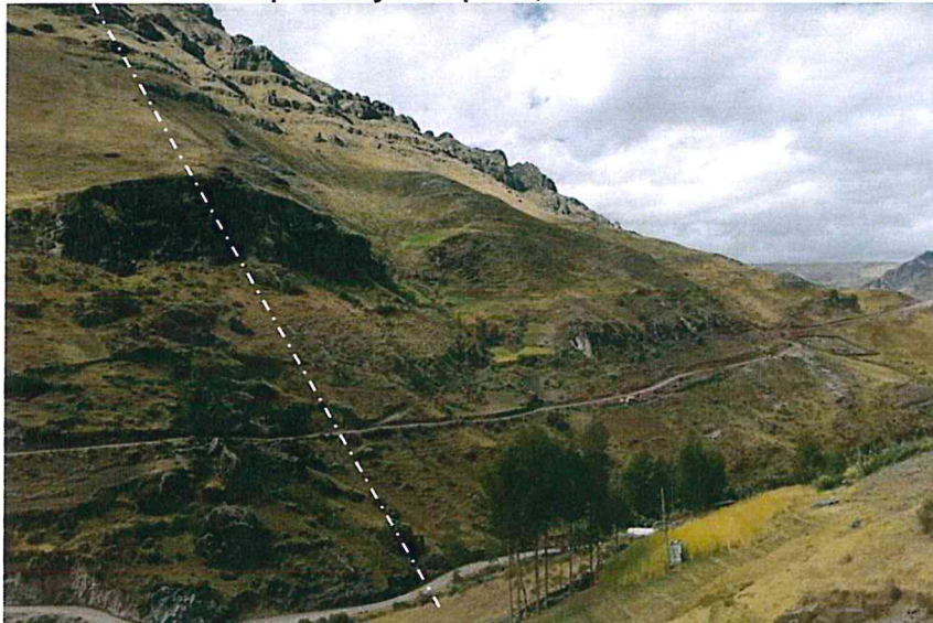
Foto 11: Laderas empinadas y escarpadas, debido a afloramientos rocosos
