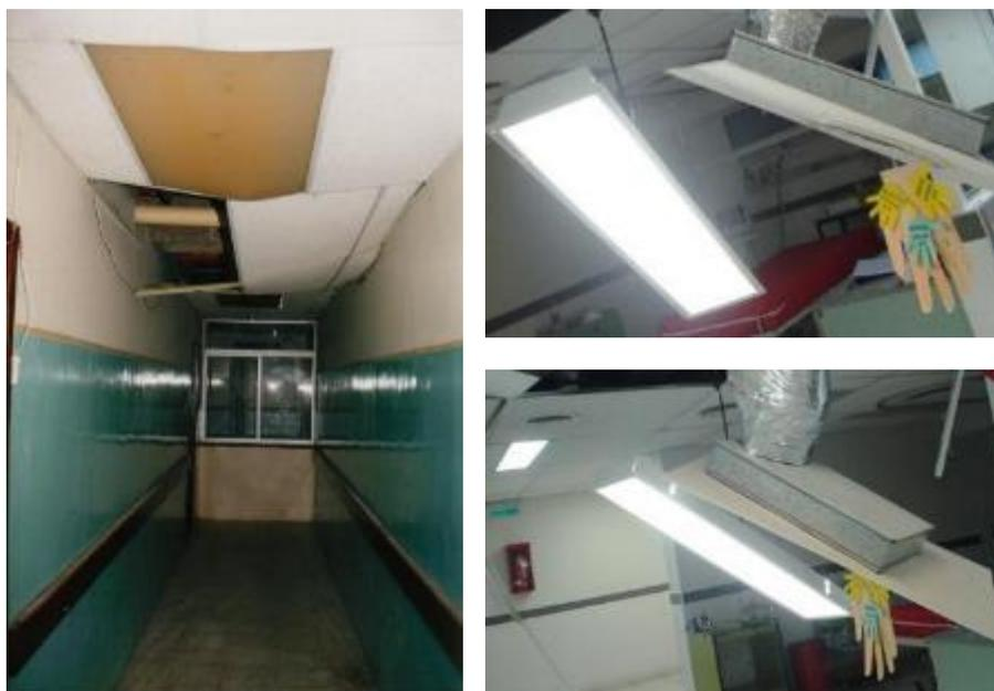
**Figura 4** falsos cielos rasos se desprenden por deficiencia en anclajes ante movimientos sísmicos
