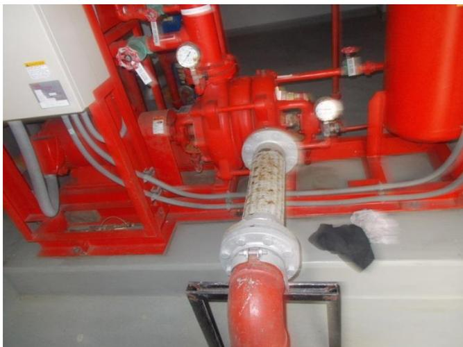
Foto 67 Tuberías de succión con uniones flexibles.
