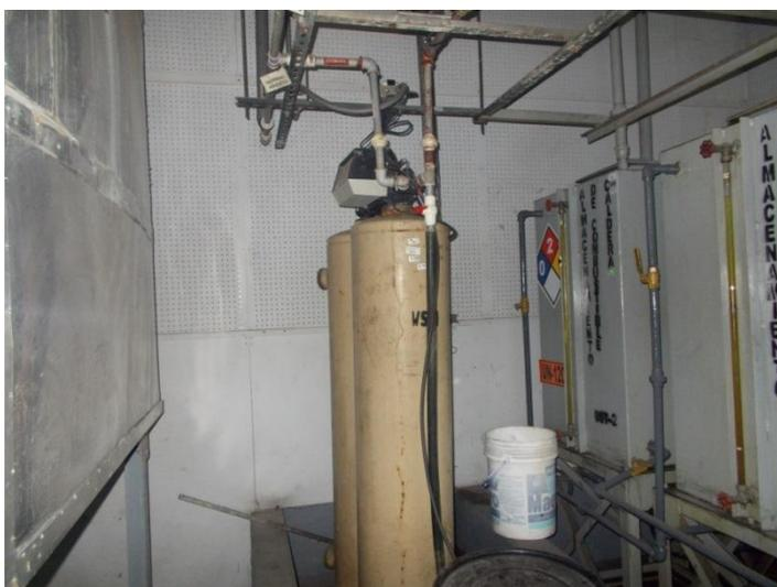
Foto 68 Sistema de ablandamiento con equipos automáticos
