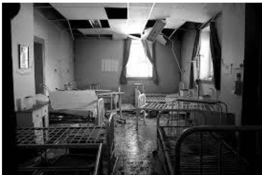
**Figura 8** luminarias no sujetadas adecuadamente en techo ante movimientos sísmos, se caen e incrementan el peso del falso cielo raso provocando colapso del sistema.
