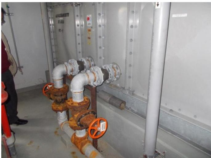
Foto 66 Tuberías de ingreso a cisterna con unión flexible
