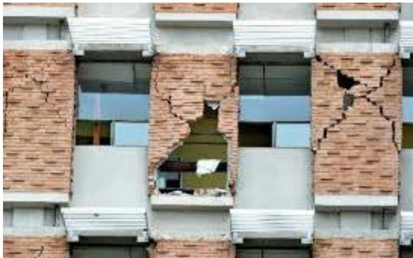
**Figura 3** Baldosas en fachadas, que se desprenden por efecto de sismos intensos
