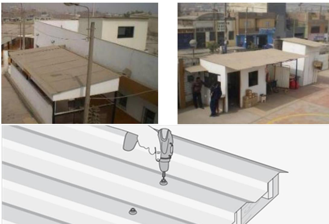
**Figura 5** Techos ligeros que deben estar sujetos adecuadamente a fin evitar caídas o desprendimientos
