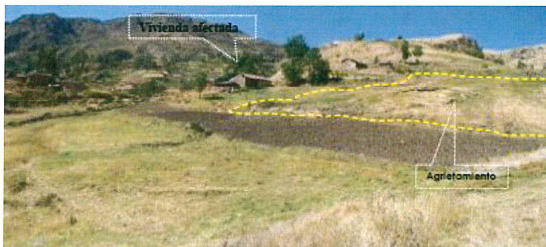
Foto 3: Vista panorámica, zona con presencia de agrietamientos, que indica un deslizamiento rotacional lento. Fuente: Gómez H. & Medina L. (2009).
