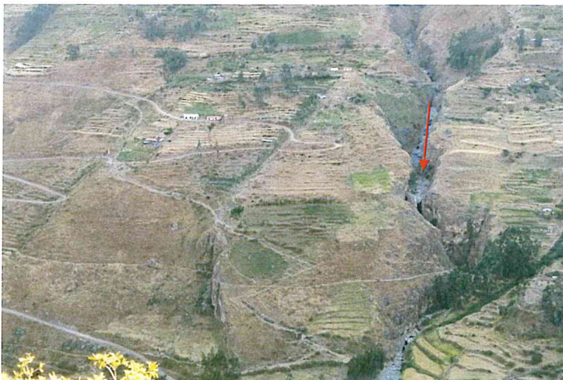
Figura N° 03: Depósitos aluviales granulares relleno cauces de quebradas.
