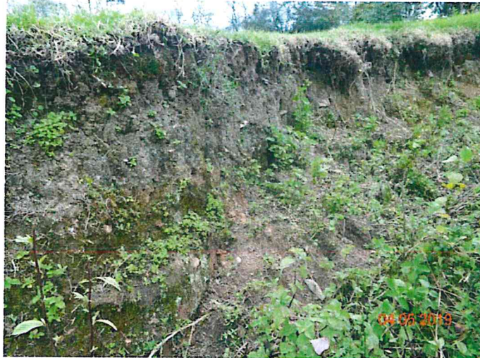
Corte en tonalita-diorita Pambarumbe. Observar la fuerte alteración química formando suelos arenos arcillosos color gris rojizo.
