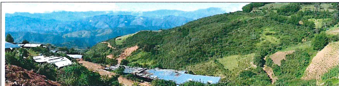
Foto N° 08.- Ladera de montaña con moderada pendiente que se extiende por la zona del sector 02 de Ayabaca. Observar el cauce de quebrada en la zona central bordeada por viviendas.
