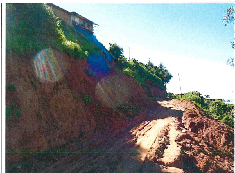
Foto N° 04.- Vista en corte de las rocas Volcánicas Lancones. Observar el color con tonalidad marcadamente rojiza con fuerte alteración química con formación de arcillas de alta plasticidad.
