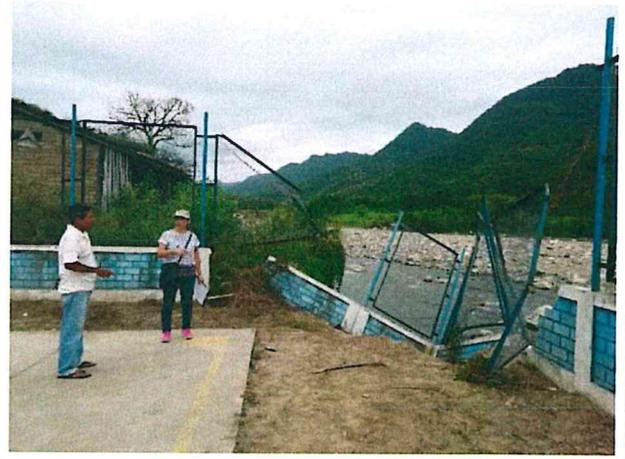
Fotos N° 22 y N° 23: Se observa vivienda en mal estado con rajaduras en las paredes y la esquina de la loza deportiva a colapsado por la socavación del cauce del río.
