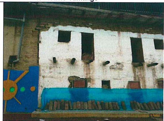
Foto N° 44: Viviendas con paredes de adobe en mal estado, cubierto con plástico por las lluvias.
