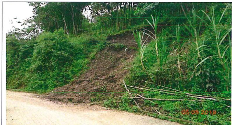
Foto N° 02.- Depósitos coluviales del cuaternario; son depósitos fragmentados formados por acción de la gravedad. Observar la fuerte alteración afectados por deslizamientos.
