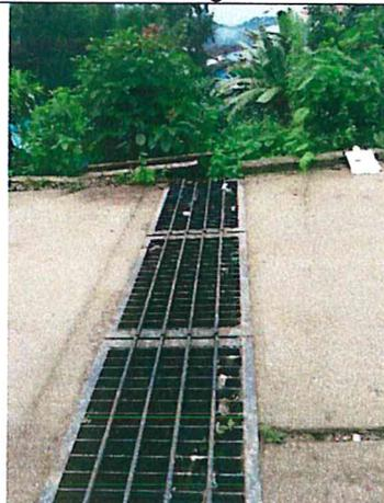
Foto N° 26: Se observa rendijas en la vía asfaltada para el desfogeo de las lluvias.
