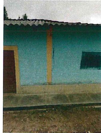
Foto N° 46: Viviendas con pared de adobe que presentan grietas y techo de Calamina, en mal estado.
