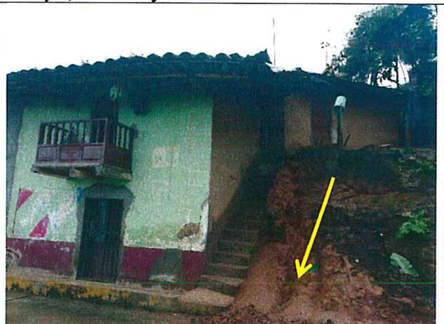
Foto N° 06: Se observa vivienda con material de adobe y techo de tejas, al costado de Corte de talud inestable.
