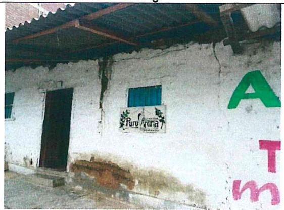
Foto N° 39 y N° 40: Viviendas con paredes de adobe que presentan grietas y techo de Eternit, en muy mal estado.
