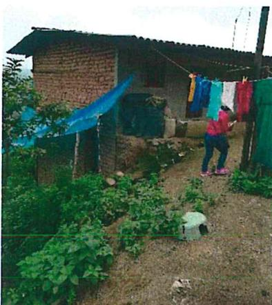
Foto N° 49 y N° 50: Viviendas de dos (2) pisos con paredes de adobe que presentan rajaduras y techo de calamina y tejas, en mal estado.
