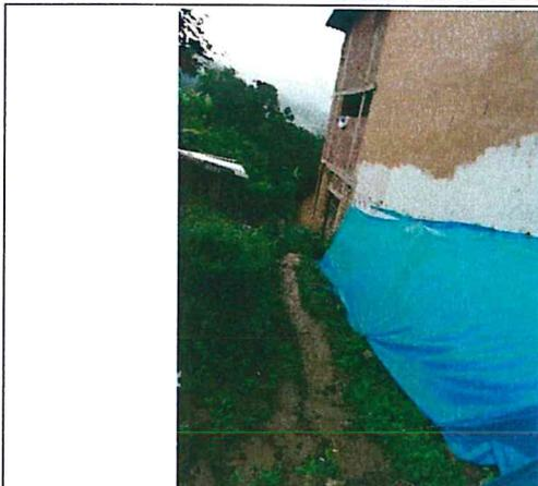
Foto N° 43: Vivienda con paredes de adobe cubierto con plástico por las lluvias.
