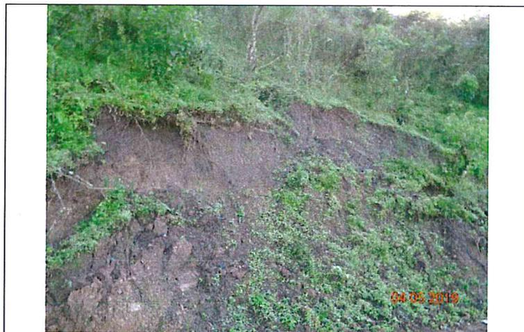
Foto N° 03.- Depósitos coluviales con fragmentos intrusivos fuertemente meteorizados afectados por deslizamientos de talud.
