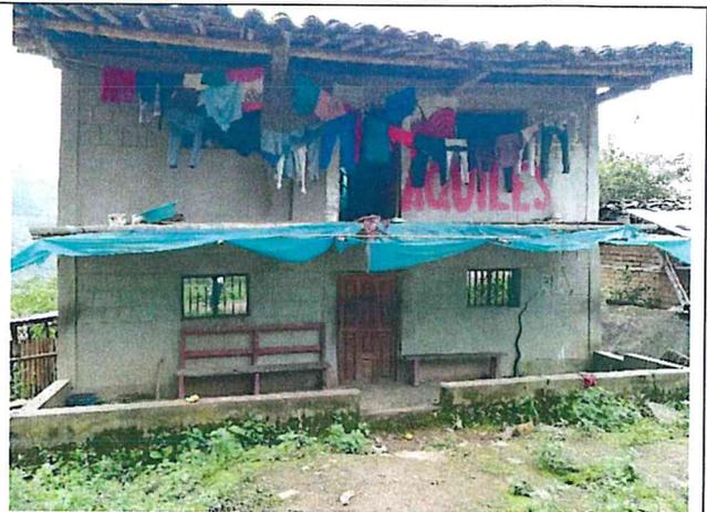
Foto N° 22 y N° 23: Se observa viviendas de 2 pisos en mal estado, con rajaduras en las paredes.
