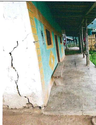
Foto N° 24 y N° 25: Se observa viviendas de adobe con rajaduras en las paredes y techo de tejas, en muy mal estado
