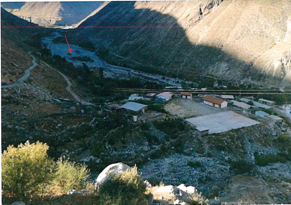
Foto 12 Cauce fluvial, se muestra encañonado y angosto
