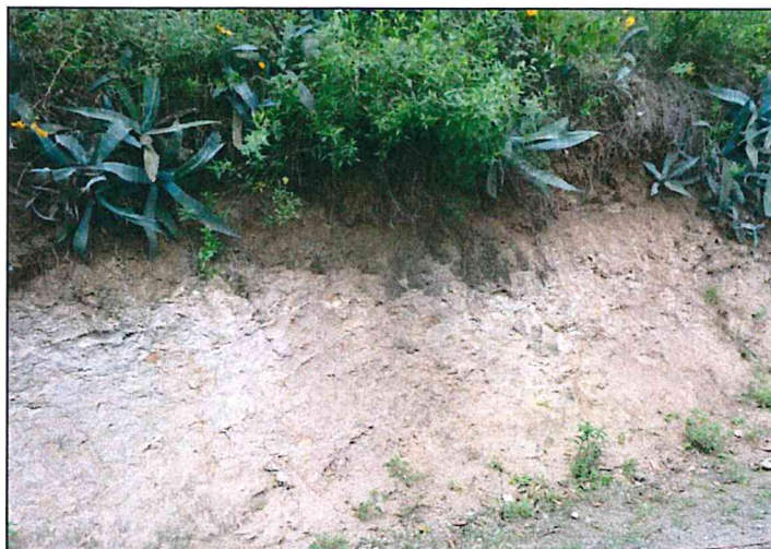
Figura N° 10 - Vista de la formación Porculla, fuertemente meteorizada y fácilmente erosionables
