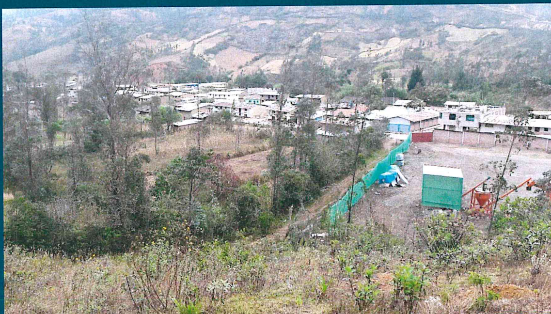
Sector 05 del Centro poblado Cuchupampa, Distrito Huarmaca-Provincia Huancabamba
