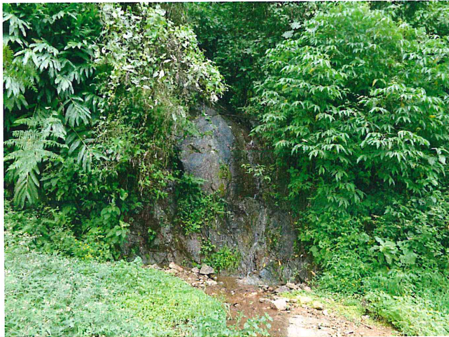
Foto 01 Vista del cauce aluvial presente en al área de estudio, corresponde a formas elongadas que causan erosión de suelos, debido al transporte de escorrentía
