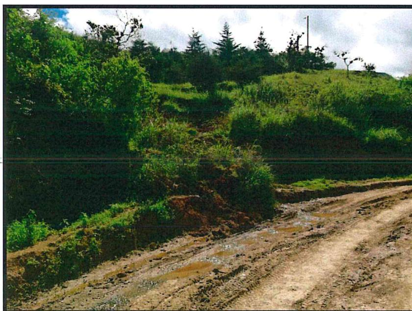
Foto 02. Estado de la vía que une los caseríos Santa Ana y Gaspar. Deslizamiento de tierra producto de la saturación de agua en el suelo.
