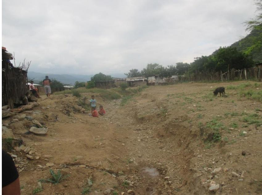
Foto 12: Quebrada de menor orden que atraviesa por las viviendas, que falta terminar de revestir de concreto hacia una quebrada de mayor orden
