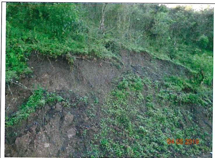
Foto N° 03.- Vista de los depósitos aluviales erosionados en las zonas laterales de las quebradas secas. Observar al acumulado de los depósitos aluviales de aspecto terrosos.
