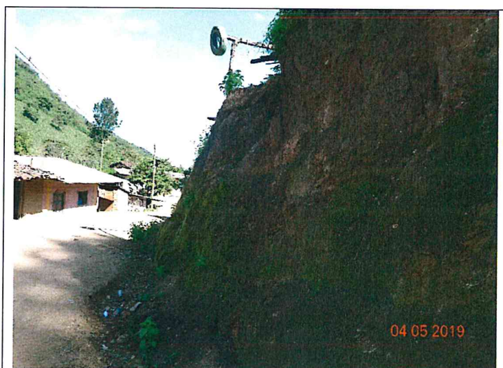
Foto N° 06.- Vista en corte de los Volcánicos Lancones. Observar la roca fuertemente fracturada y alterada por los procesos químicos supérenos de la zona lo que favorece procesos de remoción en masa.
