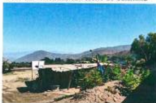
Foto 02. Viviendas con techo de Calamina
