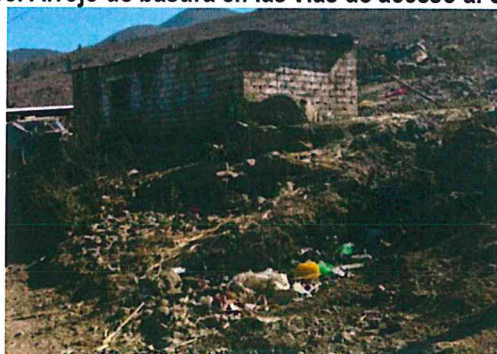
Foto 05. Arrojo de basura en las vías de acceso al Sector 2
