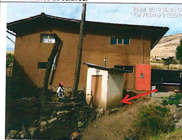
Foto N° 15: Cuenta con servicio higiénico, biodigestor.
