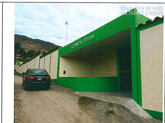
Foto N° 20: I.E. Inicial N° 1596 recientemente construido con material de concreto.
