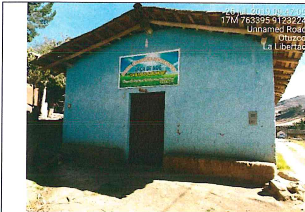
Foto N° 19: Iglesia evangélica construida con material de adobe y techo de madera.
