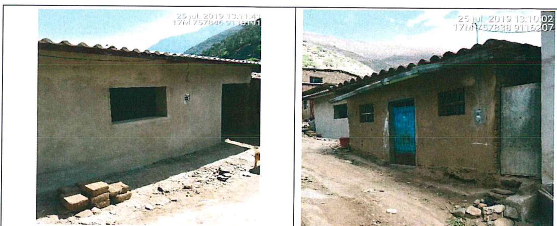
Foto N° 13: Viviendas de adobe con techos de calamina, en buen estado de conservación.
