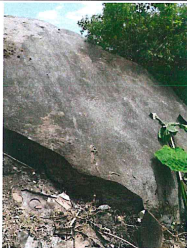
Foto N° 21: Material aluvial, roca de gran tamaño, en medio de las viviendas. Por invadir cauce de quebrada seca.
