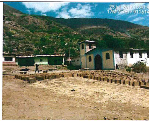
Foto 28: Iglesia de material de adobe del CP Plazapampa. Se observa en los alrededores, producción de adobes en fila.
