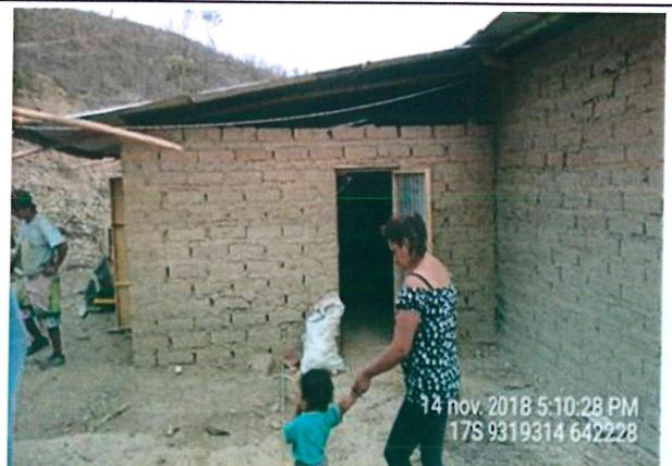
**Fotos N° 09: Viviendas de adobe con techo de calamina, en regular estado de conservación.**
