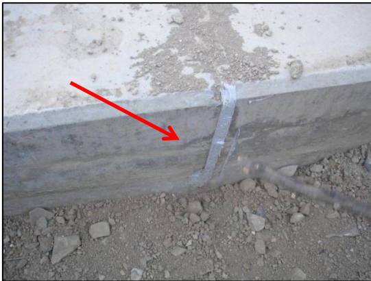
Fisura o grieta que ha sido rellenada (izq.). Más agrietamientos (der.), antes de ingresar al túnel.
