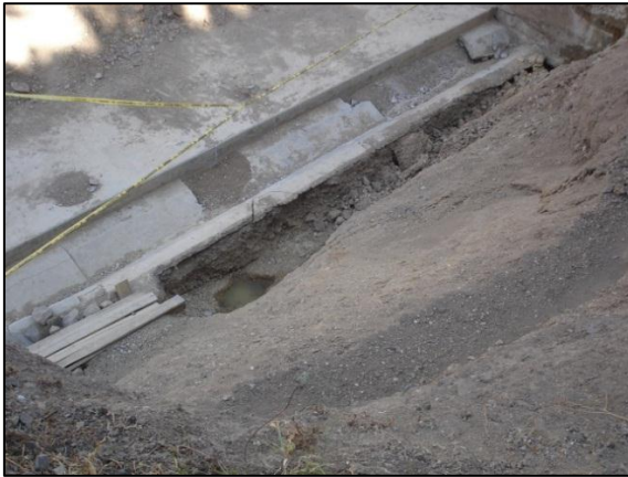
Agrietamientos en el techo del canal cubierto.
