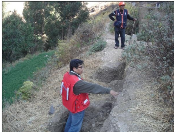
Asentamientos de terreno en la parte superior.
