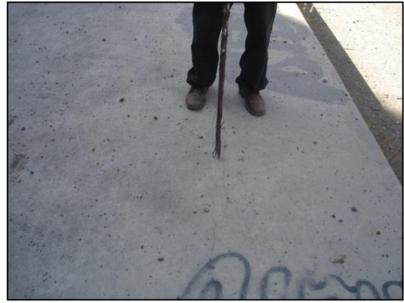
Agrietamientos en el techo del canal cubierto.
