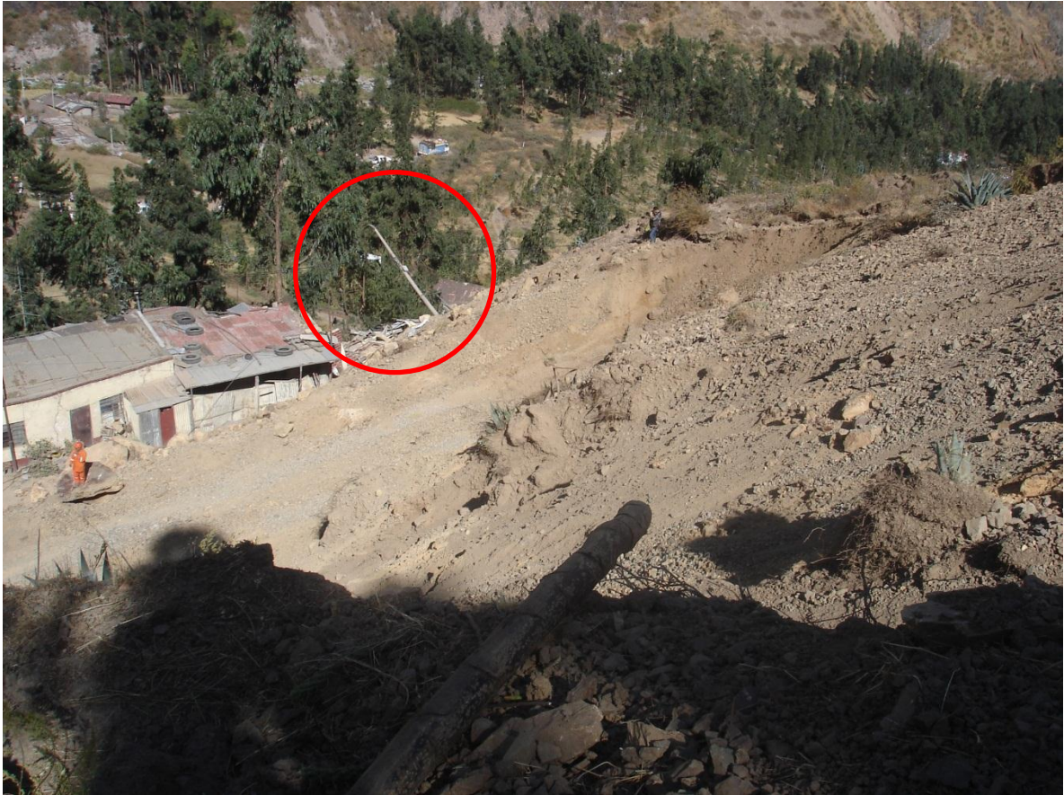
Postes de alumbrado afectados.
