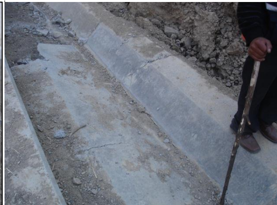
Fisura o grieta que ha sido rellenada (izq.). Más agrietamientos (der.), antes de ingresar al túnel.
