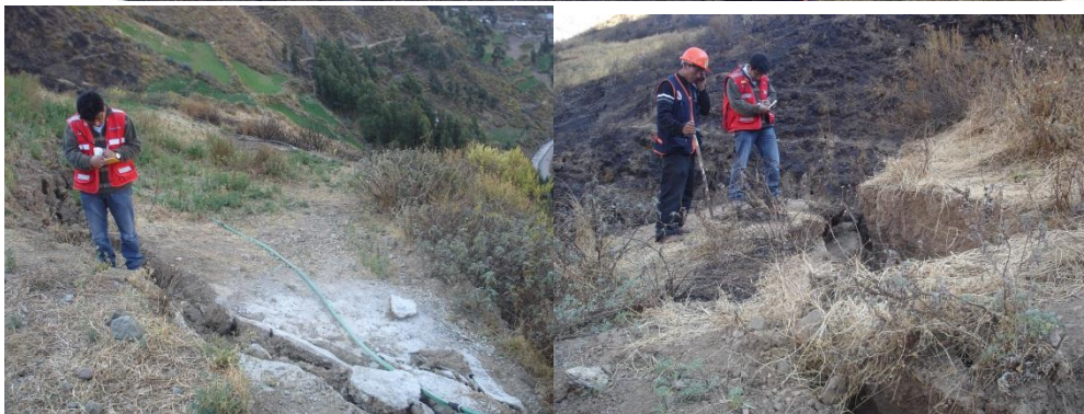
Vista de la parte superior de la ladera que muestra una superficie semicircular (escarpa del deslizamiento antiguo). Los agrietamientos y asentamientos observados aquí, evidencian la reactivación de este deslizamiento antiguo.
