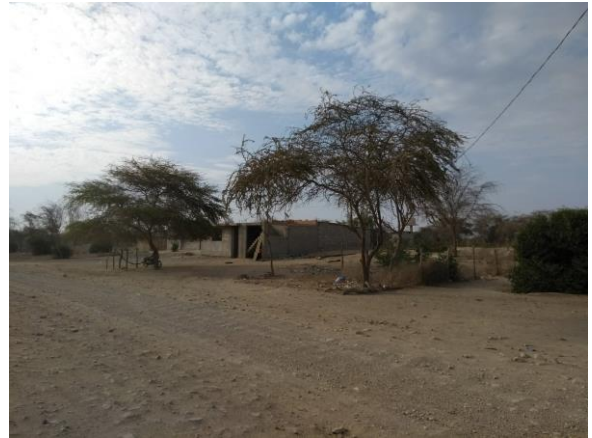
Vivienda acondicionada de bloques de cemento
