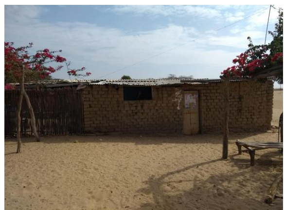
Vivienda de adobe sin ningún tipo de revestimiento y en mal estado.
