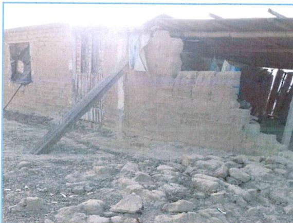
Foto N° 05: Vivienda de adobe, parte de la pared ha colapsado por las lluvias
