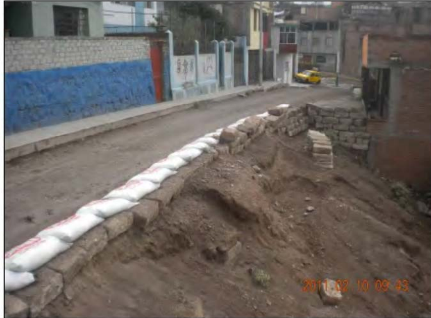
Foto N°17. Vista del tramo 5 de la calle Mollendo.
