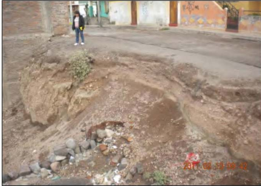
Foto N°16. Vista de la calle Mollendo (Tramo 4)
