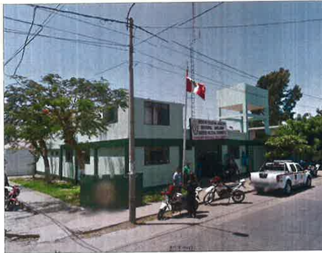
Figura 4: Postes de alumbrado público y acometida domiciliaria
