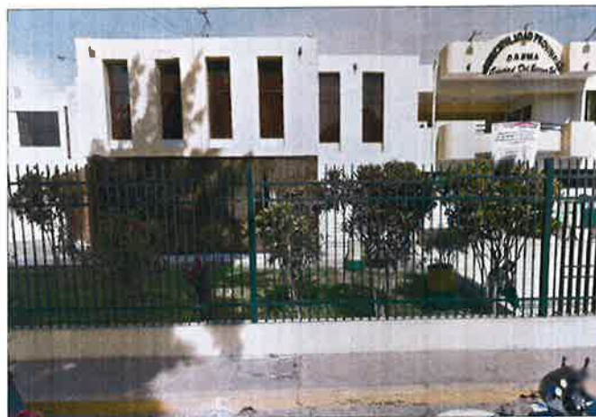
Figura 3: Conexión domiciliaria de agua potable para el Palacio Municipal
