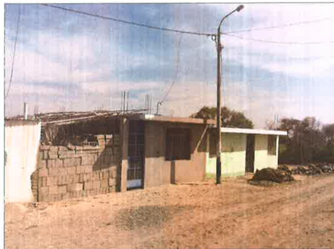
Figura 4: Postes de alumbrado público y acometida domiciliaria
