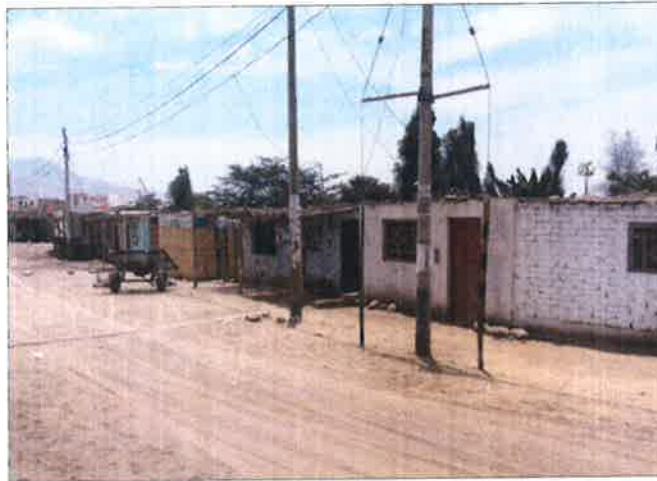
Figura 4: Postes de alumbrado público y acometida domiciliaria
