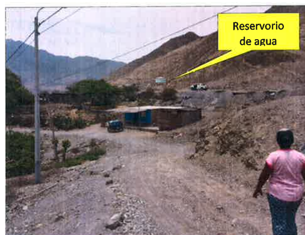
Figura 3: Reservorio de almacenamiento que distribuye agua para consumo
