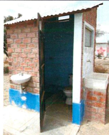
Foto N° 12: Después del evento de 2017, una ONG construyo baños completos, utilizando pozo séptico y biodigestor para reutilizar el agua para regar áreas verdes.
