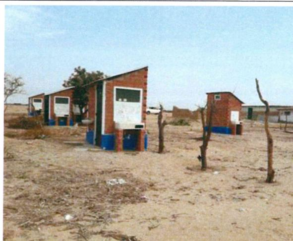
Foto N° 26: Pilón de uso público, bases erosionadas en mal estado de conservación,
