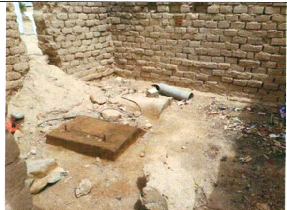
Foto N° 29: Punto de salida del agua subterránea, captada para llenar el Tanque.
