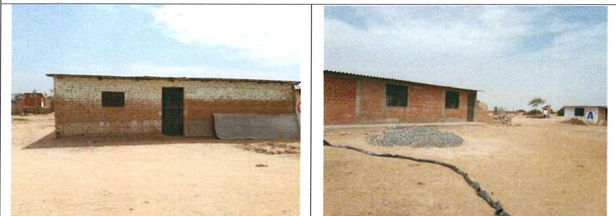
Foto N° 14: Viviendas con paredes de adobe y techo de calamina, en regular estado de conservación.
