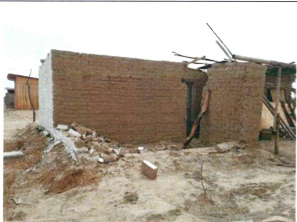
Foto N° 22: Viviendas inhabitable, parte de la pared ha colapsado.
