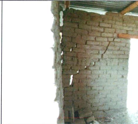
Foto N° 18: Paredes de adobe a punto de colapsar.
