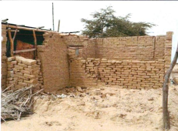
Foto N° 21: Vivienda de adobe, con paredes erosionada por las filtraciones de las lluvias que han colapsado.
