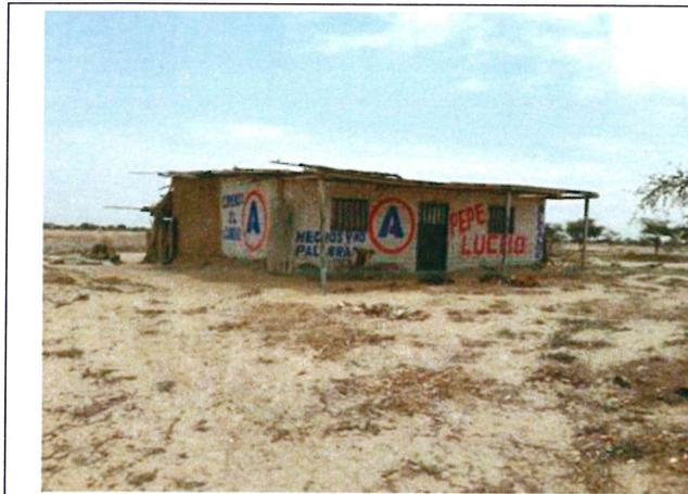
Foto N° 07: Vivienda con paredes de adobe y techo de calamina, parte posterior de la vivienda presenta grietas.
