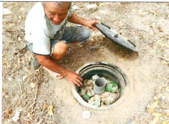
Foto N° 23: Para el tratamiento de agua de los baños cuentan con un Biodigestor.
