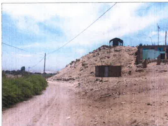
Figura 3: Reservorio de almacenamiento que distribuye agua para consumo
