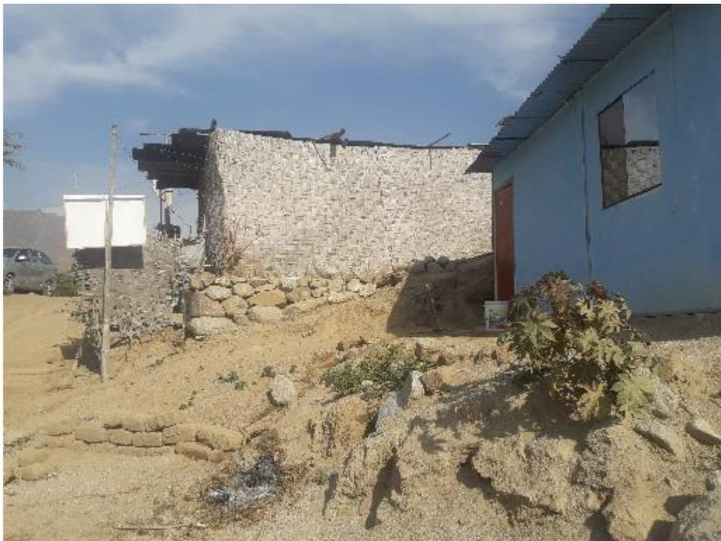
Algunas edificaciones en el centro poblado Fray Martin en estado precario construidos con muros de esteras y cobertura de calamina
