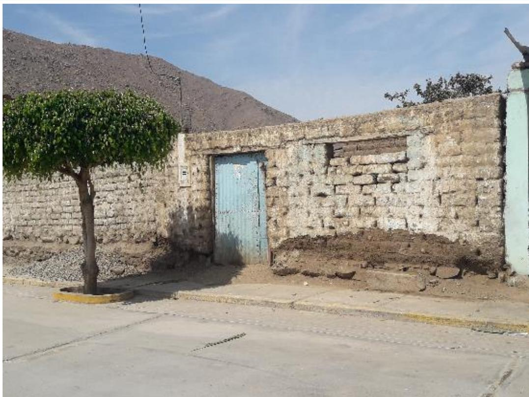
Se observa vivienda con muros de adobe en mal estado de conservación, que podría colapsar como consecuencia de lluvias intensas, sismo u otra fuerza.
