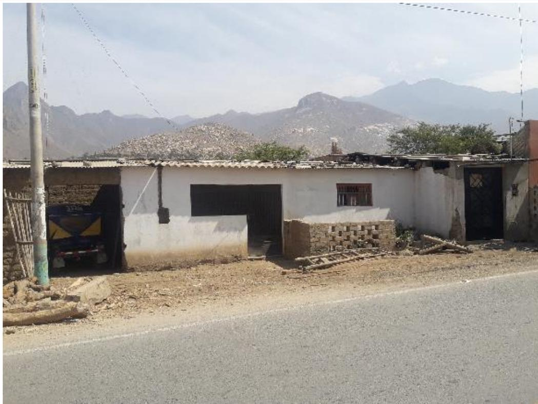
Vivienda con muros de adobe con cobertura de techo de calamina, se observa presencia de humedad en sus cimientos y en los muros fisuras y agrietamientos
