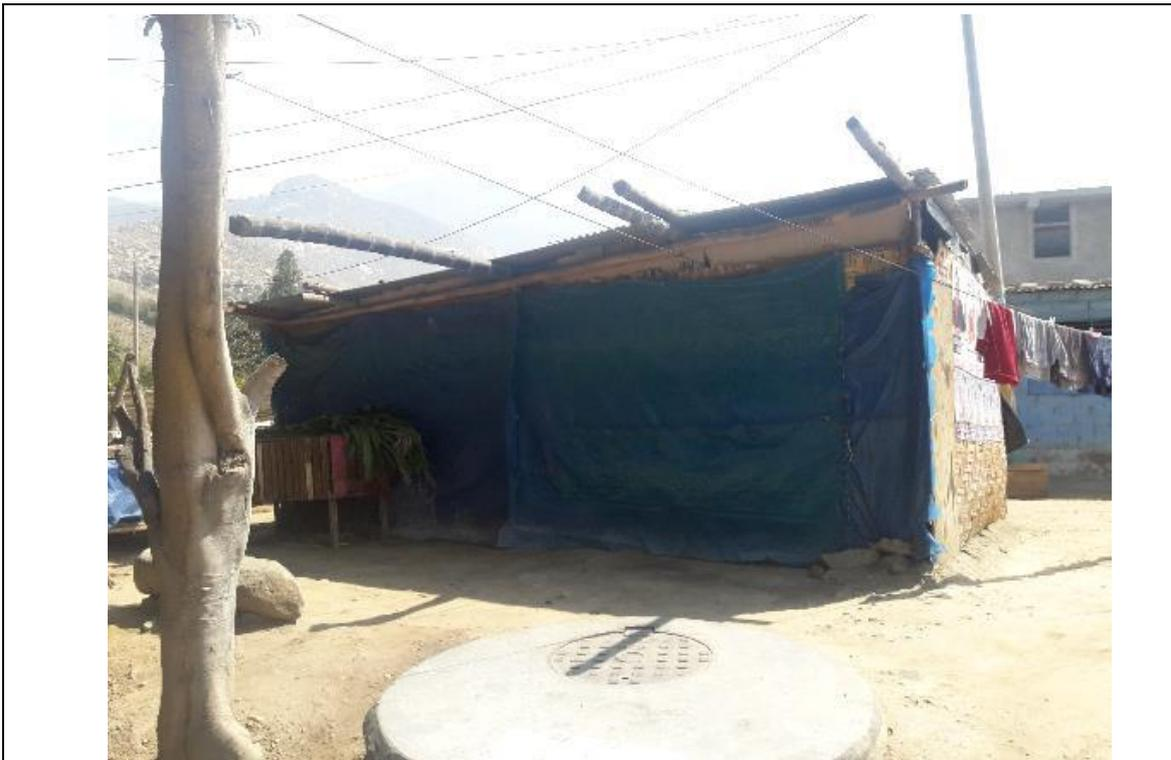
Vivienda con muros de adobe y cobertura de torta de barro, en donde se observa que parte de los muros se encuentran colapsados, en la inspección se encontraba ocupada.
