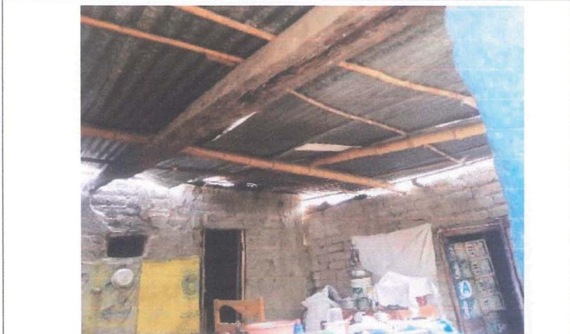
Vivienda construidos con muros de adobe y cobertura de calamina, con presencia de agrietamiento en muros en mal estado de conservación
